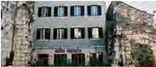
Hotel Peristil Split (Croazia)
